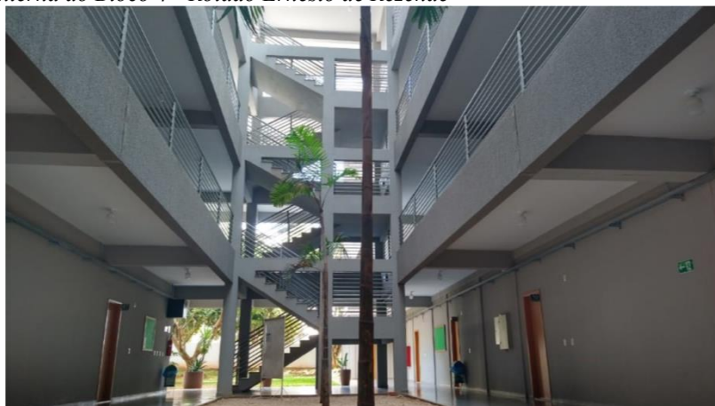
Figura 26: Vista interna do Bloco 4 - Roldão Ernesto de Rezende
